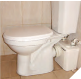
Bodrum katında bulunan tuvalet
