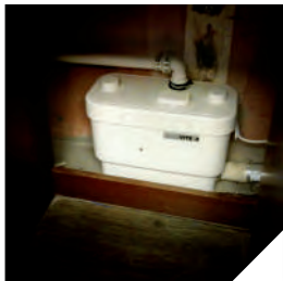
Tezgahın altına gizlenmiş SANIVITE pompa
