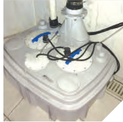
-2. kattaki depoya kurulan SANICUBIC 2 VX
