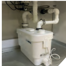
Lavabo altına kurulan SANIVITE
