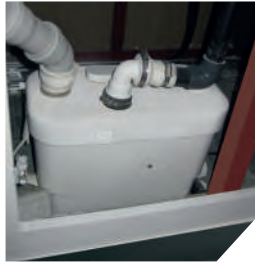
Alçıpan içine gizlenmiş SANISPEED pompa
