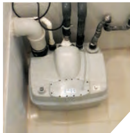
Tuvaletlerle aynı kattaki SANICUBIC 2 Classic
