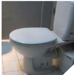
Klozetin arkasına monte edilmiş SANIPRO XR
