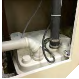
Alçıpan içine gizlenmiş SANICUBIC 1 WP
