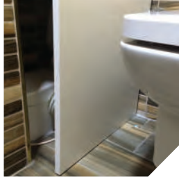
Lavabo altına gizlenmiş SANIFLO
