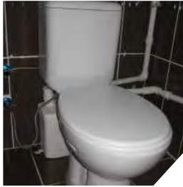
Klozetin arkasına monte edilmiş SANITOP
