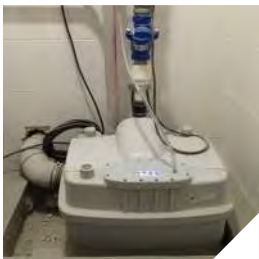
Montajı yapılmış SANICUBIC 2 Classic
