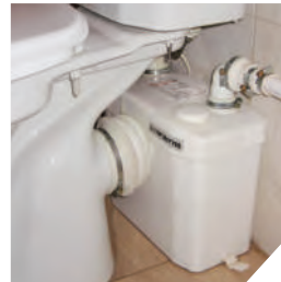
Klozete monte edilmiş SANITOP
