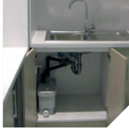
Mutfak dolabına yerleştirilmiş SANISPEED
