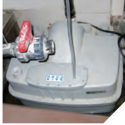
Makine odasına kurulan SANICUBIC 2 Classic
