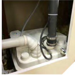
Alçıpan içine gizlenmiş SANICUBIC 1 WP
