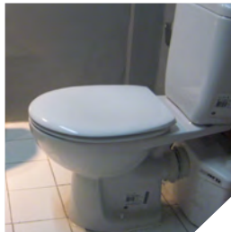
Klozetin arkasına monte edilmiş SANIPRO XR
