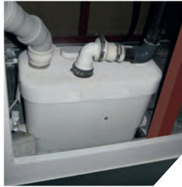
Alçıpan içine gizlenmiş SANISPEED pompa
