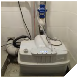
Montajı yapılmış SANICUBIC 2 Classic
