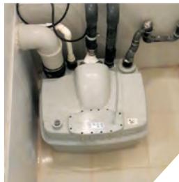
Tuvaletlerle aynı kattaki SANICUBIC 2 Classic
