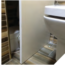
Lavabo altına gizlenmiş SANIFLO
