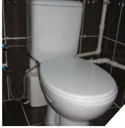
Klozetin arkasına monte edilmiş SANITOP
