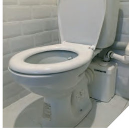
Klozetin arkasına monte edilmiş SANITOP
