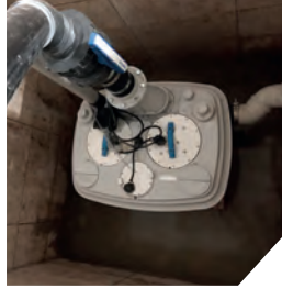
Kuyuya yerleştirilen SANICUBIC 2 VX
