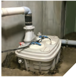
Montajı yapılmış SANICUBIC 2 VX
