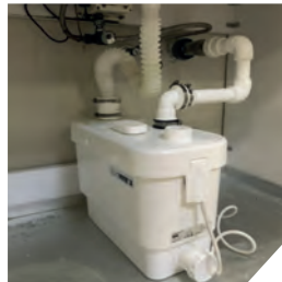
Lavabo altına kurulan SANIVITE
