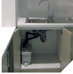
Mutfak dolabına yerleştirilmiş SANISPEED
