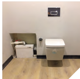
Duvara gömülüp kapakla gizlenecek SANIPACK
