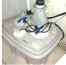
-2. kattaki depoya kurulan SANICUBIC 2 VX
