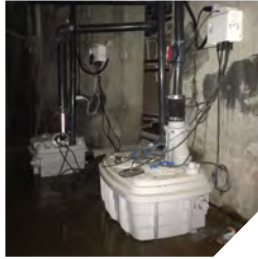
Soyunma odaların arkasındaki depo bölümü
